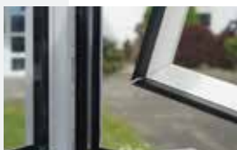
aluminium profiel met flexibele kunststof flens
